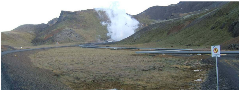
Mynd 12.6 Heföbundnar lagnir ofanjarðar með Z-útfærslum.
