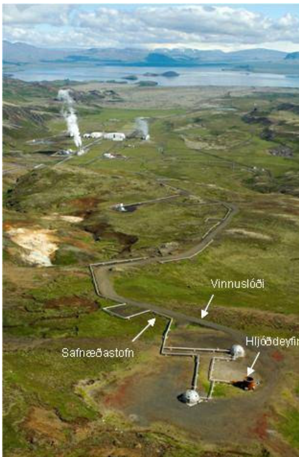
Mynd 12.9 Dæmi um borteig, hljóðdeyfi, safnæð og vinnuslóða meðfram lögn. Mynd er tekin á Nesjavöllum.
