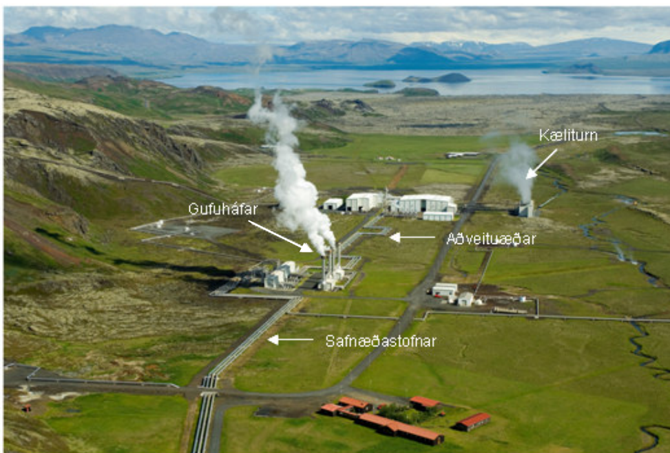
Mynd 12.11 Dæmi um aðveituæðar. Myndin er tekin á Nesjavöllum og sýnir safnæðar að skiljustöð, gufuháfa og aðveituæðar að stöðvarhúsi. Á myndinni sjást einnig fjórir gufuháfar.
