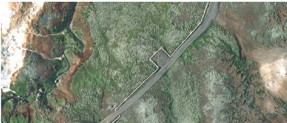
Mynd 12.8 Hefðbundnar lagnir ofanjarðar séð úr lofti. U-útfærsla fyrir miðri mynd, Z-útfærsla undir veg neðst á myndinni.
