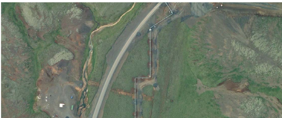
Mynd 12.7 Heföbundnar lagnir ofanjarðar með Z-útfærslum séð úr lofti á framkvæmdatíma.
